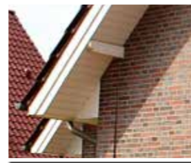
Giebelüberstände mit sichtbaren und profilierten Fuß- und Mittelfettenköpfen
